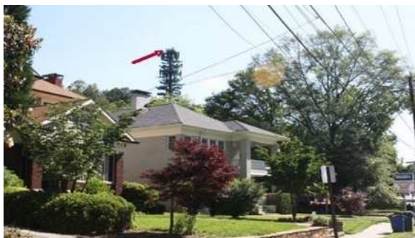
Fig. 13. Antene GSM instalate și camuflate în copaci-sursa internet
